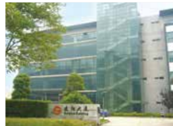
Accretech (China) Co., Ltd.
