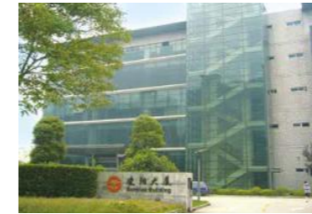
Accretech (China) Co., Ltd.
